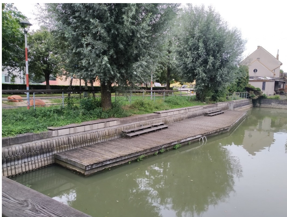
Stávající stav dřevěného mola
