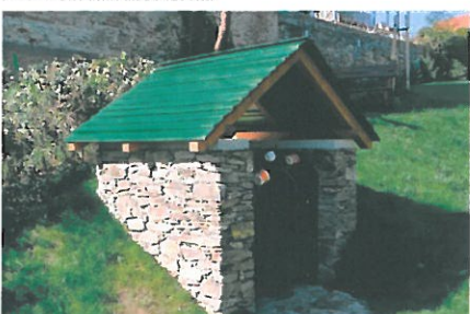
2019 – Rekonstrukce studánky pod Stavimatem
