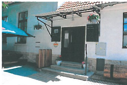
2021 – Rekonstrukce objektu restaurace Na Valdeku
