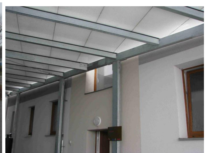
Zastřešení dvora při OÚ Braškov v roce 2015
