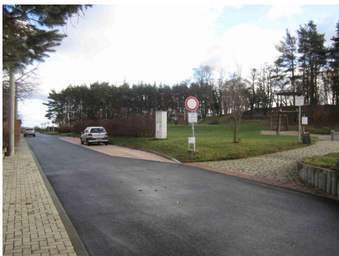
Komunikace ul. K Háji v roce 2015
