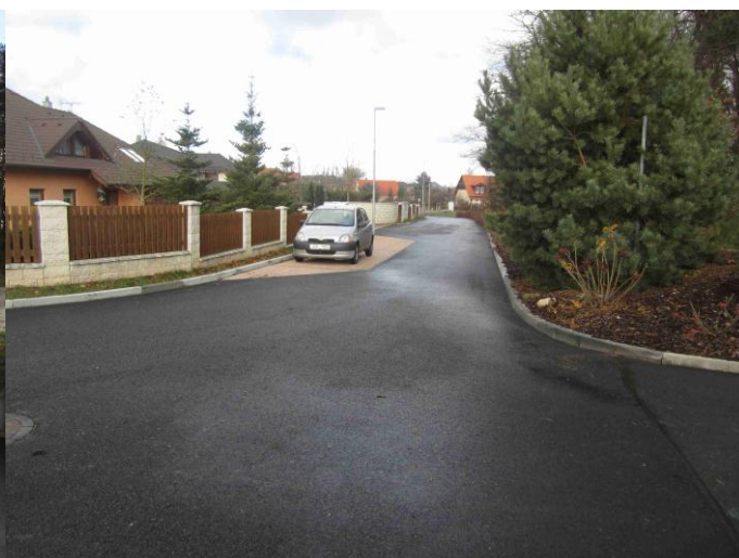
Komunikace ul. Akátová v roce 2015
