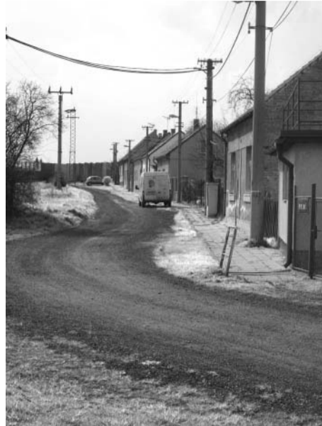
Ulice Polní – před rekonstrukcí
