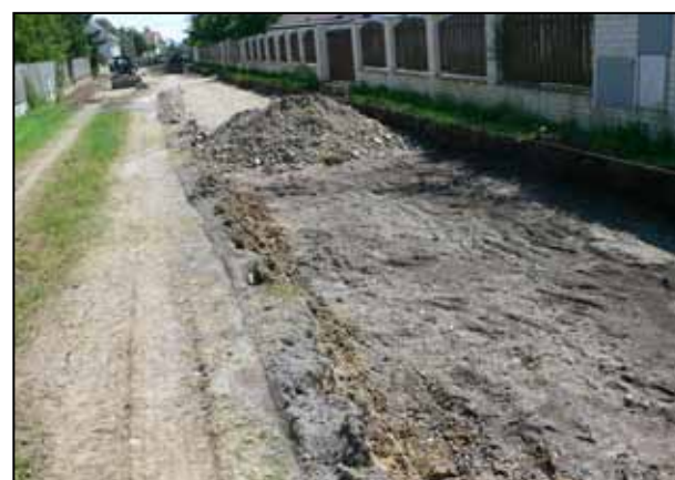
PRÁCE NA ULICI KHÁJI
