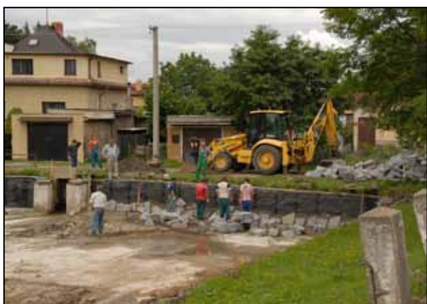
PRÁCE PŘI STAVBĚ VALDECKÉ HRÁZE
